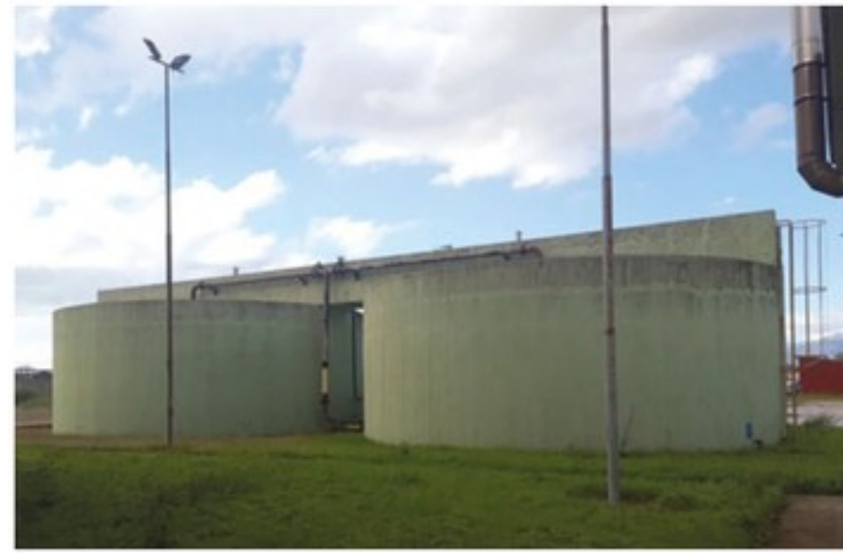
Un progetto co-finanziato dalla Regione Toscana: Bio2Energy, impianto in grado di produrre biocombustibili da scarti organici da rifiuti e da fanghi di depurazione
